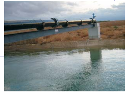
SUSTITUCIÓN DE BOMBEO
