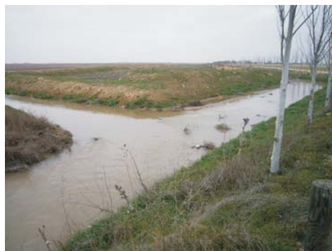
Conexión Balazote con Laguna de Acequión
