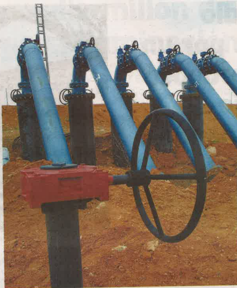
Tomas de la sustitución de bombes en la Mancha Oriental. / A.P.
