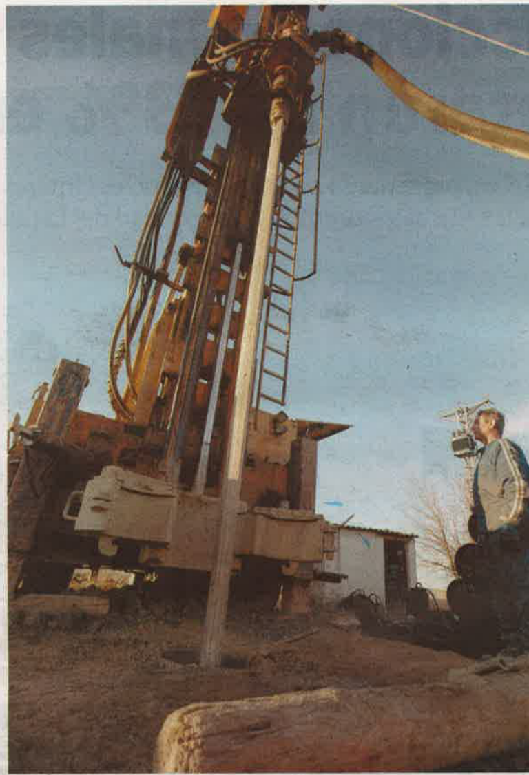
Perforación de un sondeo para extraer agua del subsuelo. / J.C.C.
