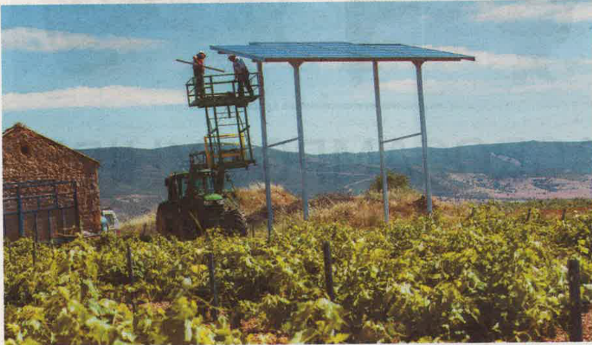
Instalación de un equipo solar para regar un viñedo, en una imagen de archivo. / RUEDA VILLAVERDE
