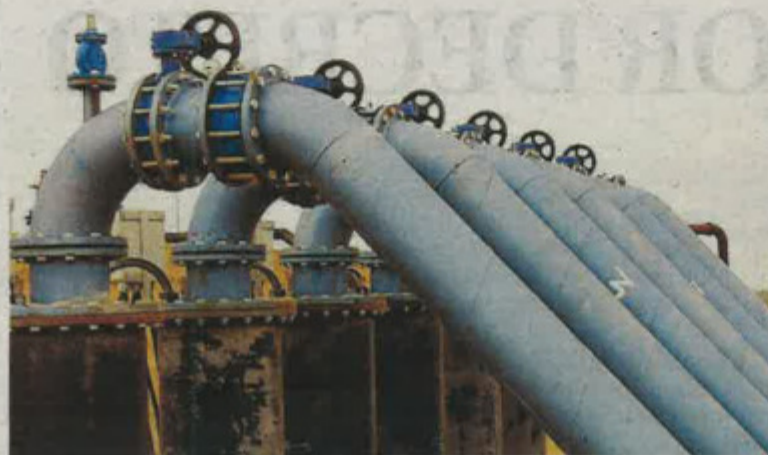
Tomas de la Fase Uno de la Sustitución de Bombeos. J.A.P.
