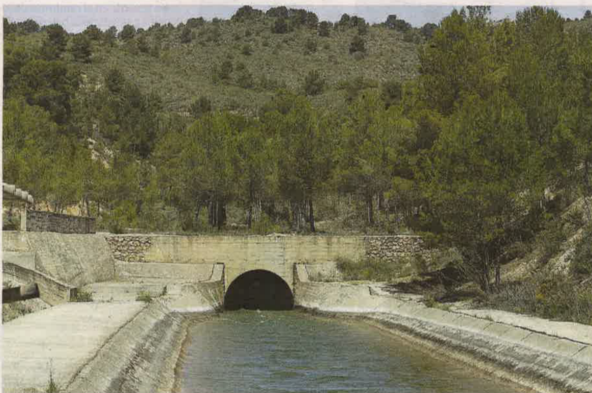
Boca de la salida del Túnel del Talave, en Liétor, donde empieza el tramo final del ATS. / REBECA SERNA
