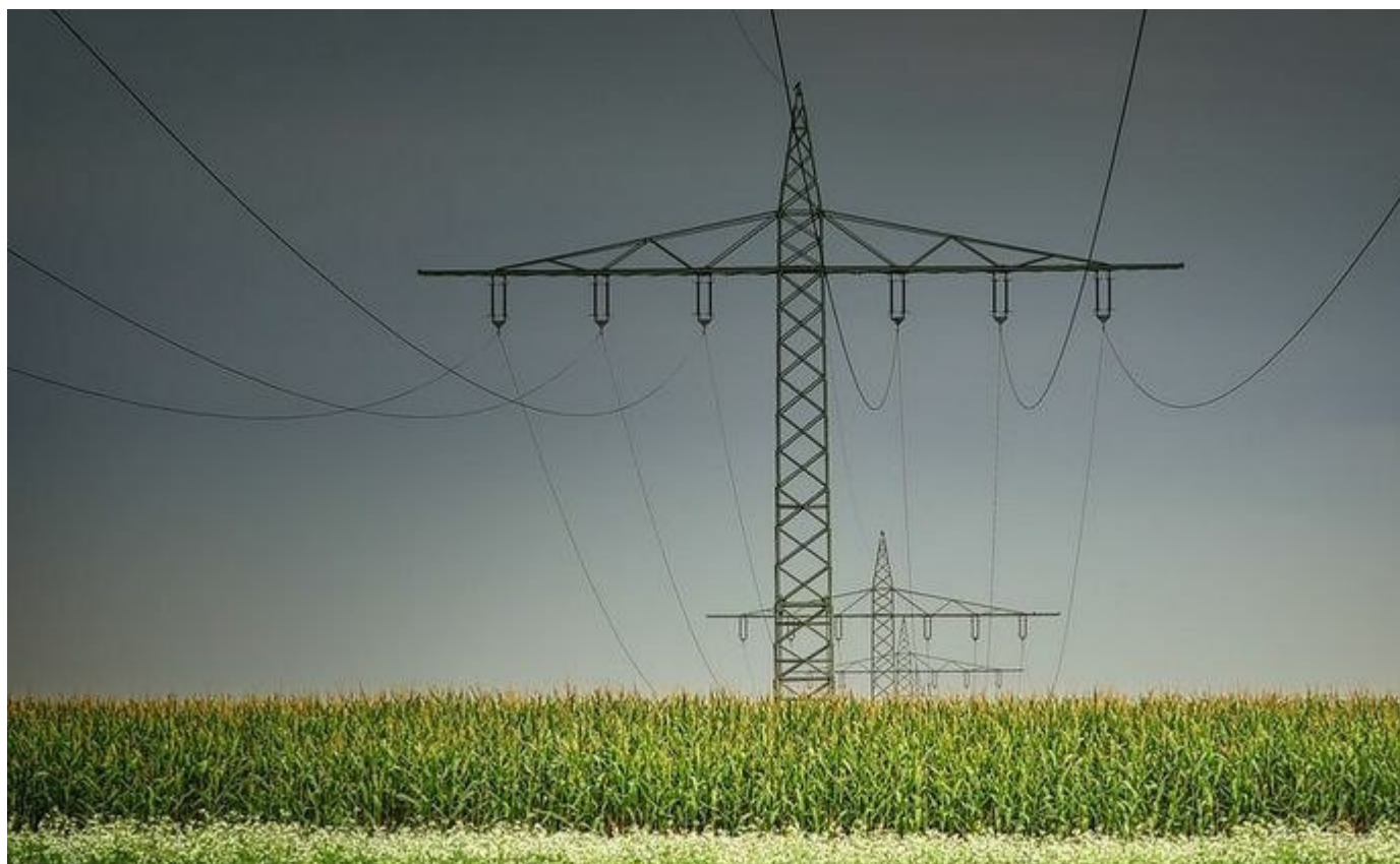
Poste de electricidad / Feragua
