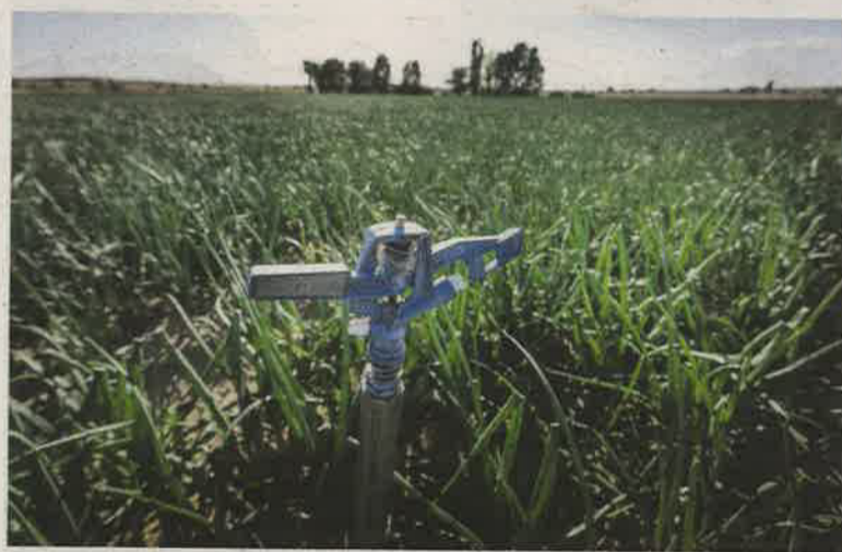
Vista en detalle del cabezal de un aspersor. / E.G.M.
