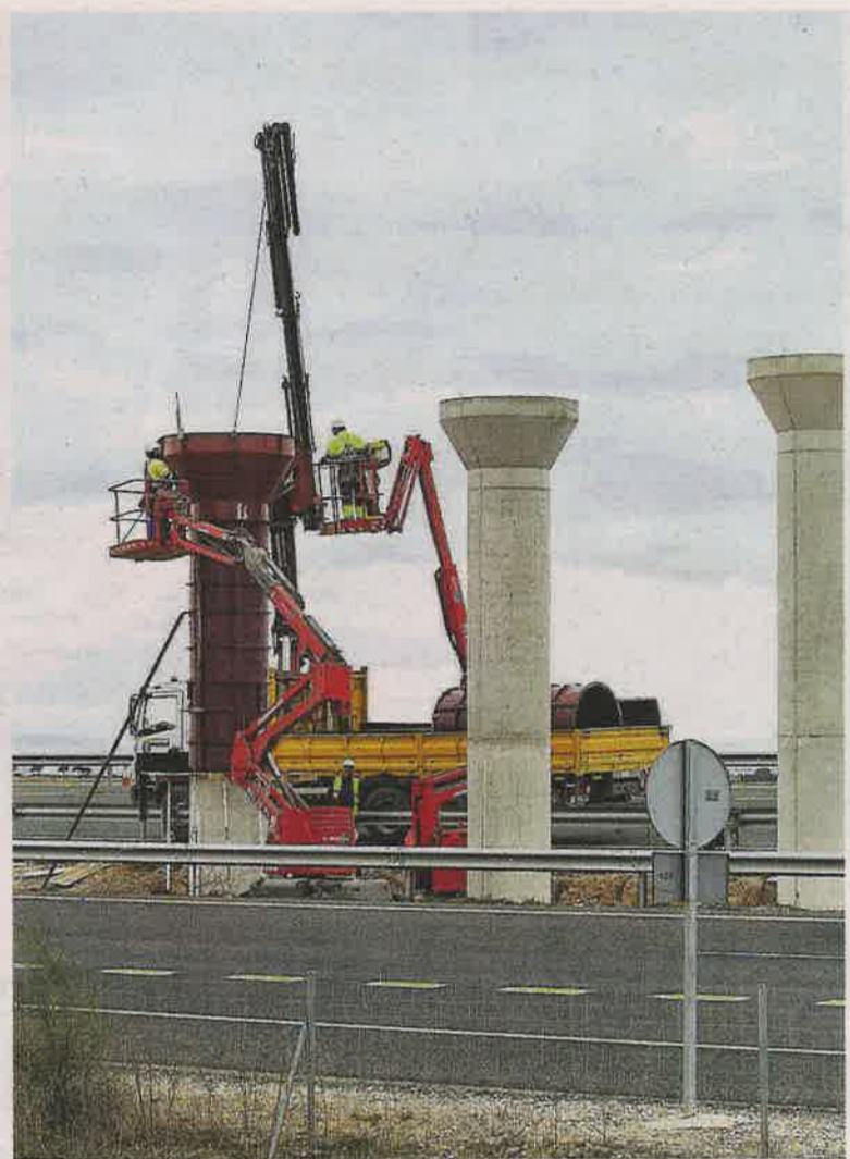
Imagen de archivo de las obras de la Circunvalación Sur de Albacete. / R. SERRALLÉ
