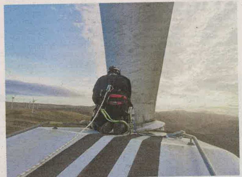
Un técnico de Ingeteam revisa un aerogenerador. / INGETEAM
