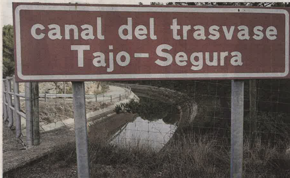
Canal del Tajo-Segura a su paso por la región. / R.M.
