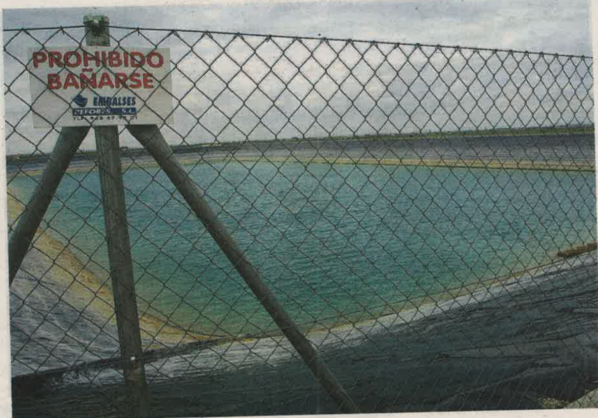
Balsa de regulación de sustitución de bombeos correspondiente a la zona regable de La Herrera. / A.P.
